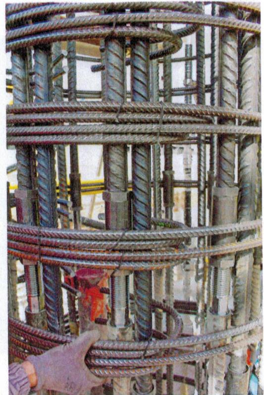
Utilisés sur les grands chantiers de construction ou les zones de forte sismicité, les coupleurs se substituent au recouvrement traditionnel des armatures.
